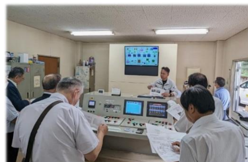
出口川湧水処理施設
